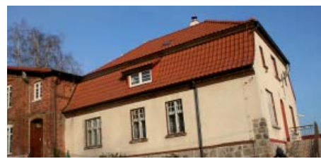
Dach po remoncie
