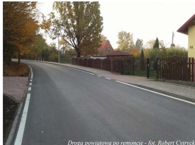
Droga powiatowa po remoncie - fot. Robert Cytrycki
