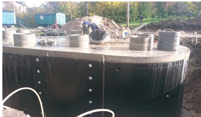
Montaż oczyszczalni, fot. A. Kulma
